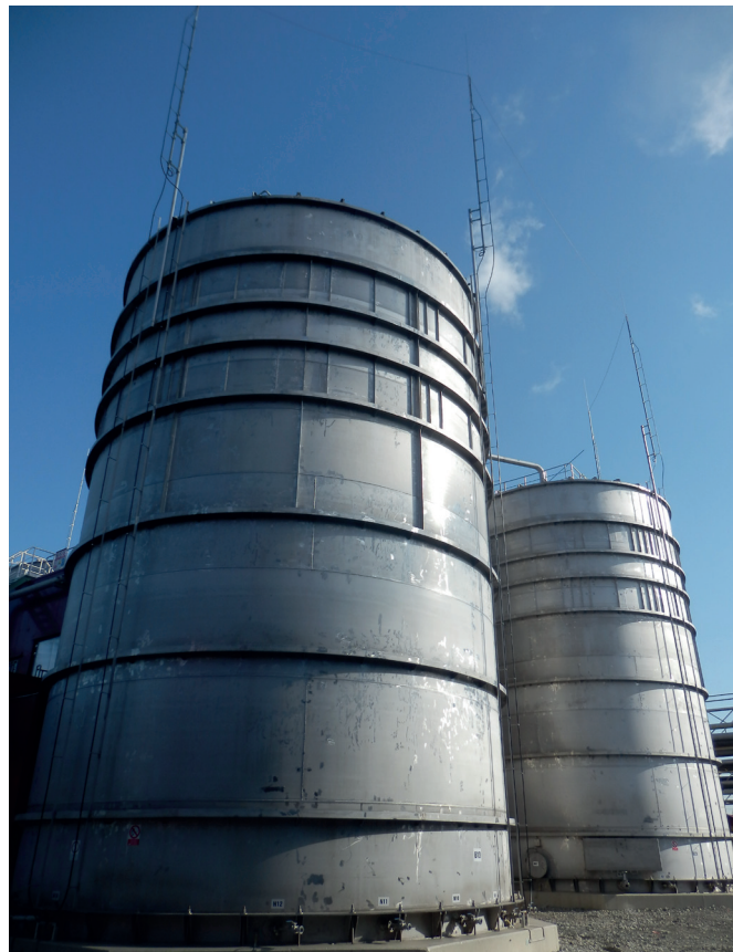
Obr. 6 Instalace vodiče HVI long v prostředí s nebezpečím výbuchu
