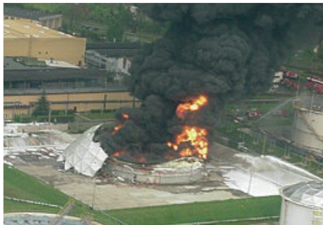
Obr. 3 Trzebinia, Polsko Požár tanku rafinérie způsobený bleskem
